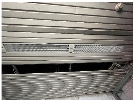
Dettagli controsoffittatura con installazione corpo illuminante – piano tipo
