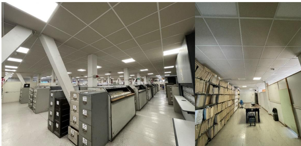
Controsoffittatura con installazione corpo illuminante – Area archivio (piano terra – piano primo)
